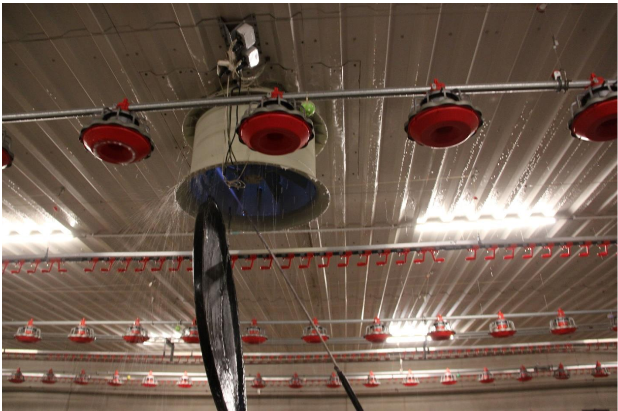
Poistoilmahormien puhdistus on oleellinen osa erätaukopesua ja -desinfiointia
